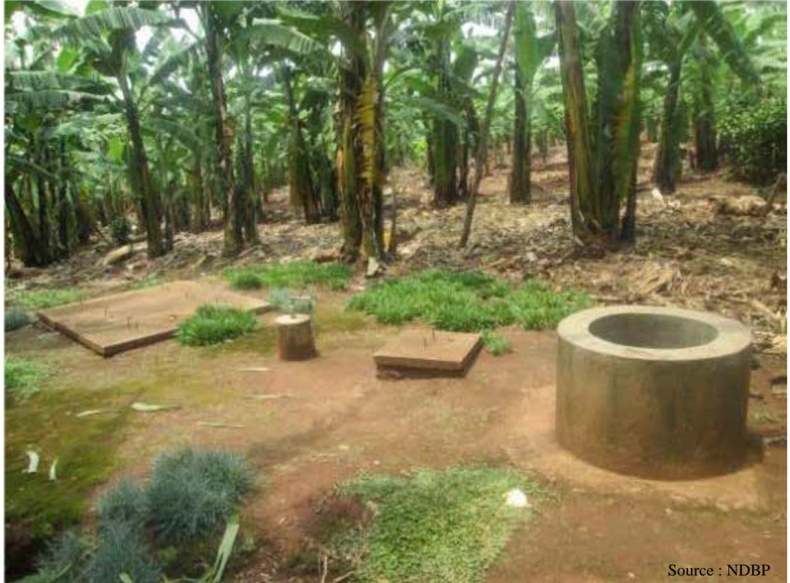
Figure 16: Digesteur rwandais de type chinois (Rwigema, 2015)
