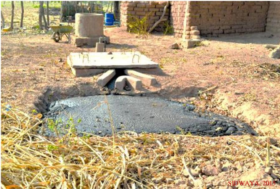
Figure 25: Biodigesteur modèle GGC 2047 du PNB (photo : SIDWAYA 2015)
