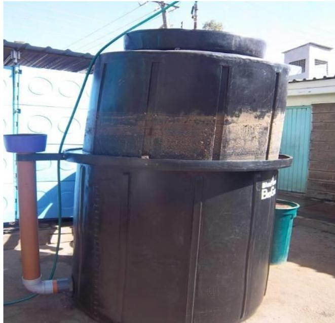
Figure 19: Digesteur kenyan à dôme flottant en plastique (Karki et al., 2015)
