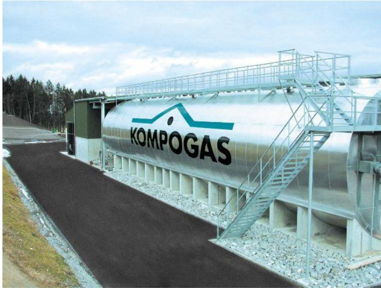
Figure 9: Digesteur Kompogas (Kompogas, 2007)
